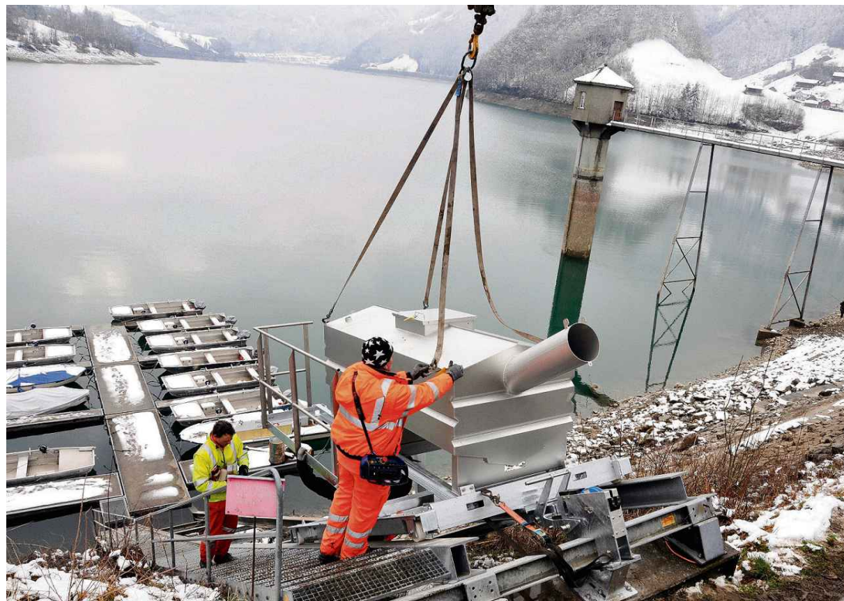
Installation der neuen Fischbahn: In diesem Container werden die Forellen künftig auf Schienen hinunter ans Ufer gefahren.
